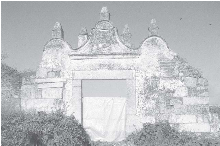
Fig. 2: Puerta de llamada de las Atalayas en el lugar donde debió erigirse el Palacio Grande del Coso
