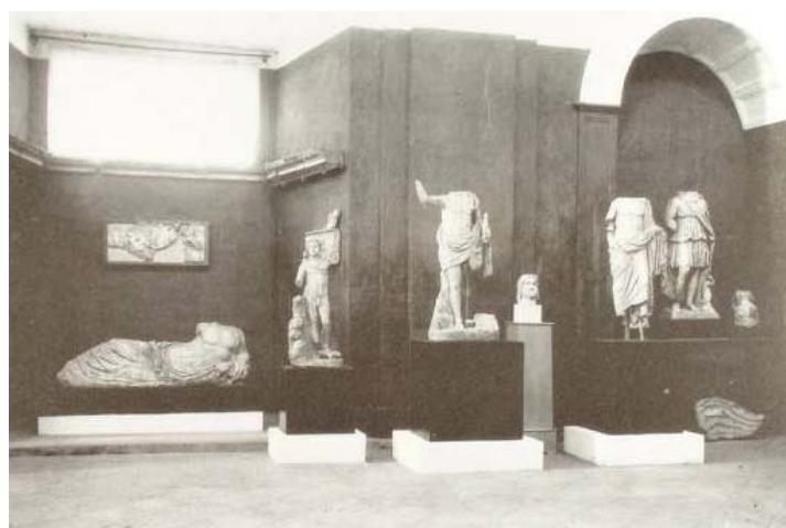
Fig. 11. Interior del Museo de Mérida, cuyo montaje fue llevado a cabo entre 1929 y 1930.
