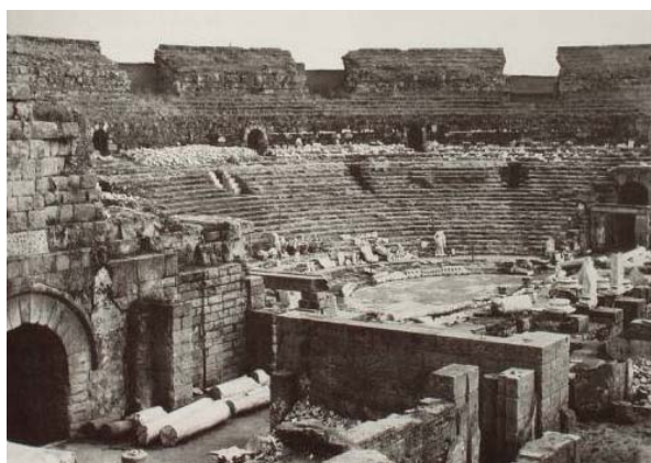
Fig. 10. Labores de restauración y reconstrucción en el teatro emeritense a principios de siglo.
