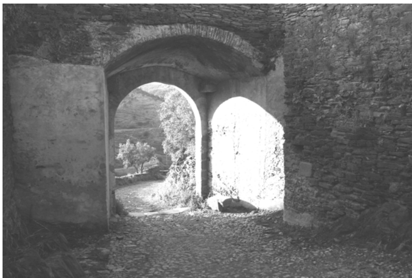
Figura 11. Interior de la puerta de Enmedio
