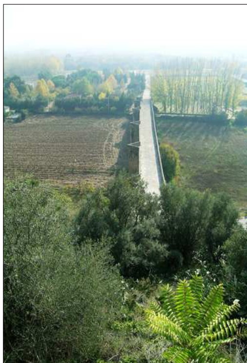
Fig.12. Puente abandonado por el río Alagón en Coria (Cáceres). Foto: E. Rebollada.
