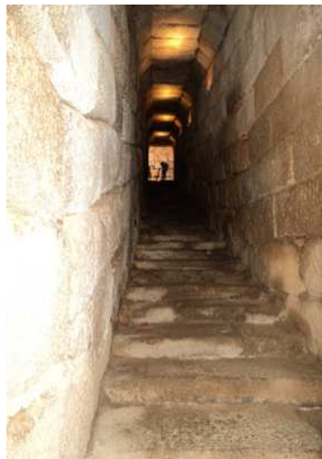
Fig. 20. Rampa inclinada de bajada. Foto: A. Llanderas.
