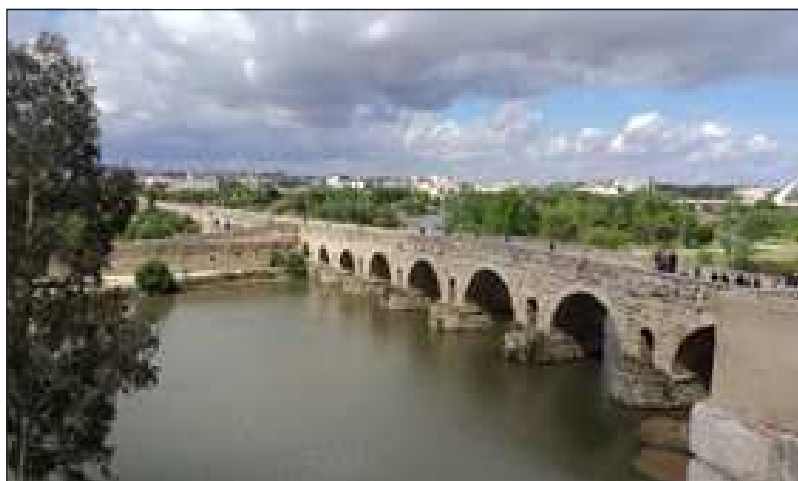
Fig. 22. Puente romano de Mérida. Foto: A.Llanderas.
