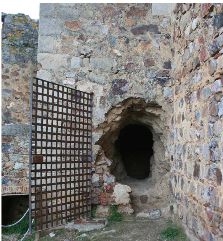
FIG. 3: Agujero abierto en la Torre del Guadiana del Castillo de Medellín.
