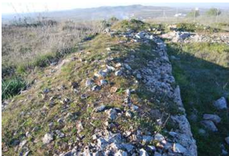
Imagen 6: Muro de la torre del homenaje.
