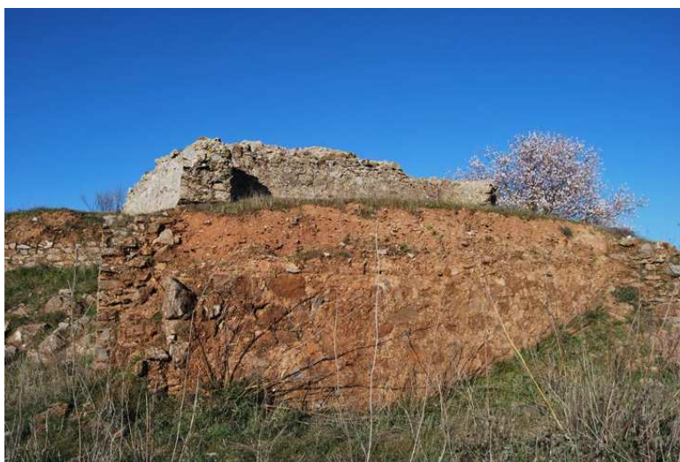
Imagen 2: Núcleo de tapia con forro de mampostería junto al aljibe.
