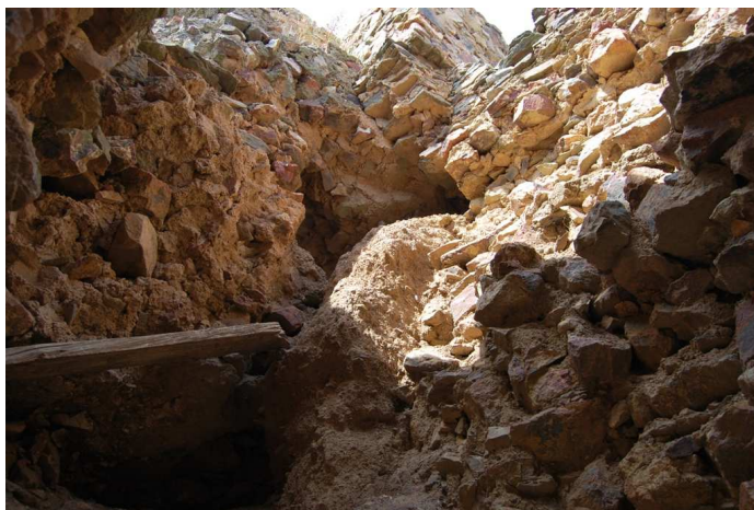
Figura 8: Castillo de Feria, núcleo de tapia y refuerzo de mampostería en el ángulo suroeste del castillo.
