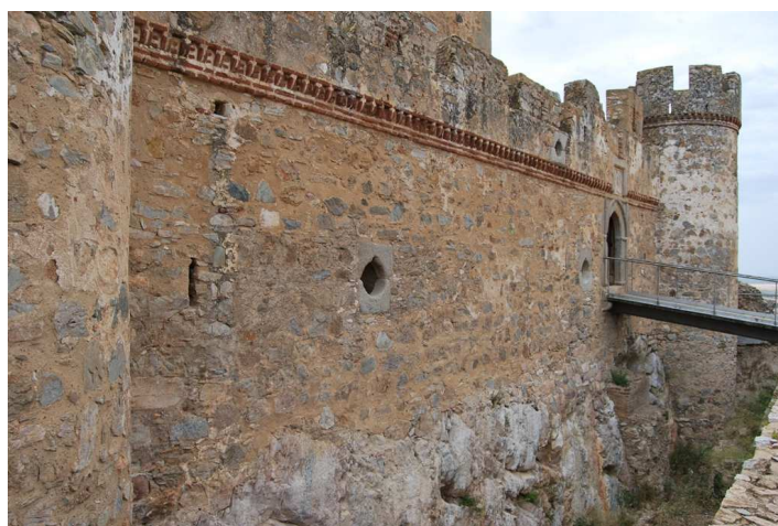
Figura 3: Castillo de Nogales, barrera y foso, lado sureste.
