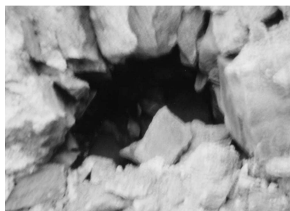
Fig. 9. Detalle de la bóveda de la cloaca por la parte sur (cuyo tramo está soterrado debajo de la calle Gallego Paz).
