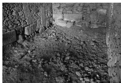
Figura 62. Interior de la ermita de San Nicolás, actualmente establo, en su construcción se utilizaron grandes sillares romanos
