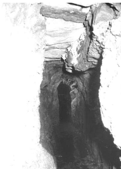
Fig. 24. Detalle del comienzo del tramo descubierto del acueducto de Cúriga, con techo de lajas de piedras.
