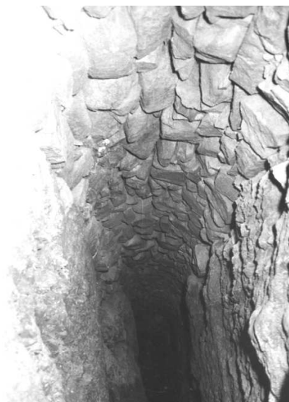
Fig. 23. Detalle de la bóveda de medio punto del acueducto de la ciudad romana de Monesterio.
