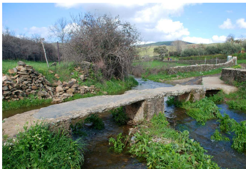
Fig. 5. Puente de las tres lanchas (De la Llave)
