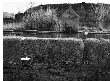
Fig. 54. Detalle de uno de los sillares romanos utilizado en el "Pilar Viejo", con una característica muesca rectangular
