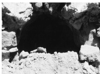
Fig. 10. Detalle de la bóveda de la cloaca en la sección que quedó al descubierto en la mitad del solar (Norte).
