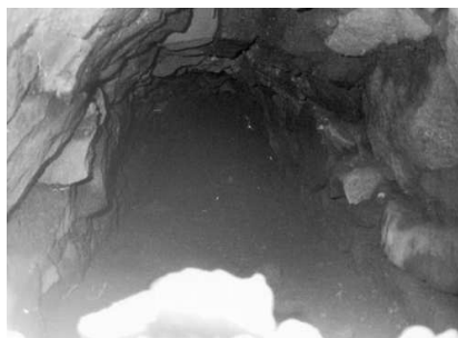
Fig. 4. Detalle del interior de la Bóveda de medio punto de la cloaca del Cardo Máximo de Cúriga
