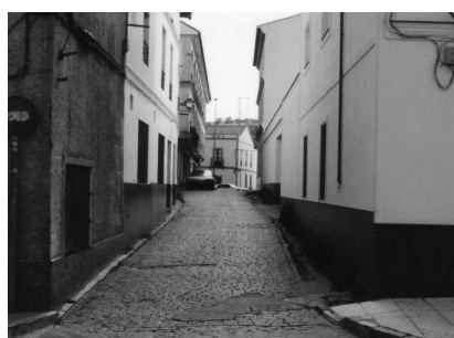
Fig. 11. Calle Gallego Paz en 2001, antes de remodelarse. En la derecha, la esquina con Templarios núm. 1
