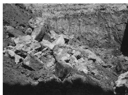
Fig. 13. Imagen de las labores de desescombro del solar en el que apareció la cloaca del oppidum de Cúriga en 1999. Se aprecian, algunas estructuras, destruidas durante esas labores, de opus caementicium , (arena, cal y guijarros).
