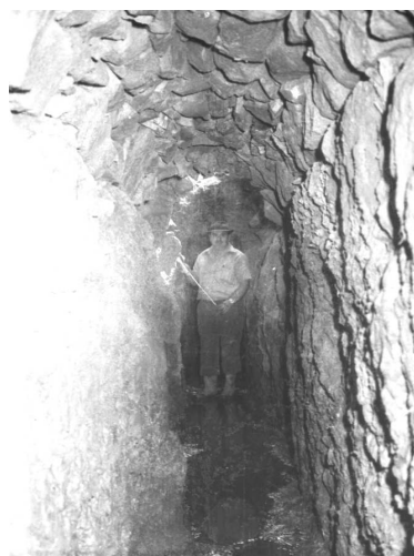
Fig. 22. Don Francisco Bautista Oliva, Maestro Nacional, se fotografía dentro del acueducto de Cúriga.
