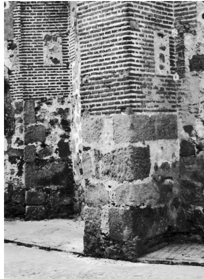
Figura 50. Detalle del arranque de uno de los contrafuertes del ábside de la Parroquia de Monesterio construido con sillares romanos
