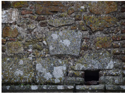
Fig. 51. Detalle de una dovela incrustada en la pared de la iglesia (encima de la puerta cegada de la Plaza del Mercado)
