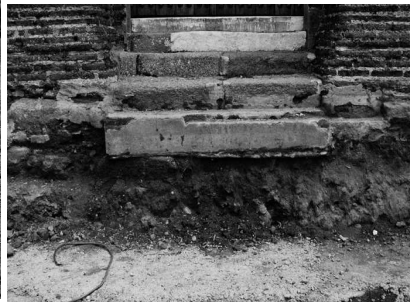
Fig. 48. Detalle de los escalones, formados por sillares, de la "Puerta del Sol" de la Parroquia de Monesterio en 2004, hoy ocultos.
