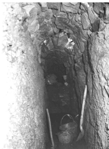
Fig. 21. Acueducto soterrado de la ciudad romana de Cúriga, imagen tomada hacia 1977.
