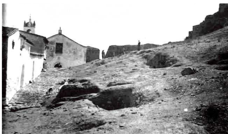
Fig. 11. Ladera norte del Castillo de Alburquerque, donde Cabrera proponía que había un poblado troglodita. En la fotografía pueden apreciarse los socavones de los que él hace mención. Alburquerque 1916.
