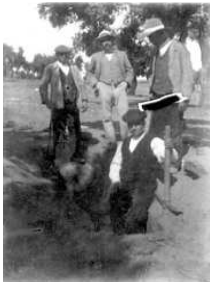
Fig. 16. Trabajos de excavación en una cista en Valdigüelo
