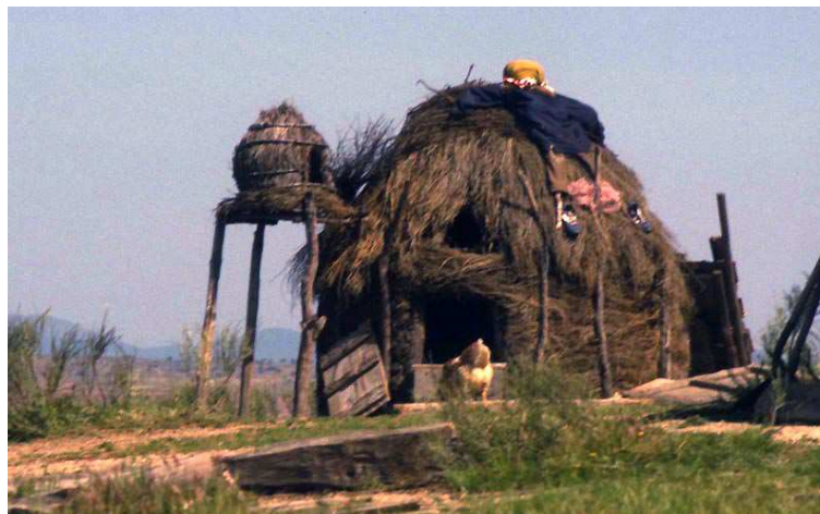
Fig. 3: chozo pequeño o chofardo , en este caso destinado a gallinero (obsérvese el tablero-puerta situado a la izquierda del vano de acceso, así como el “minicho” para las gallinas cluecas )
