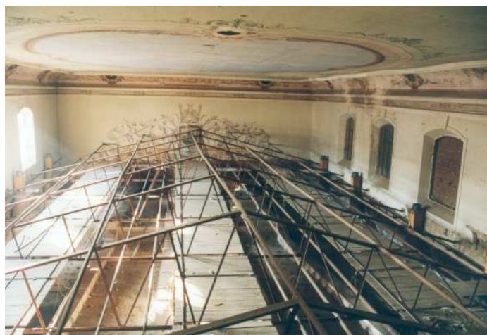
Figura 16. Fotografías del falso techo en el patio de butacas. [LÓPEZ BERNAL, V.]
