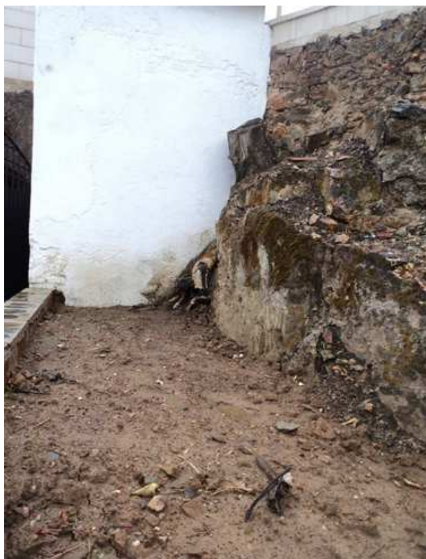
Figura 9. Hastial Oeste del filón Costanaza junto a la carretera. Pozo emboquillado en el filón. Foto: A. Llanderas.
