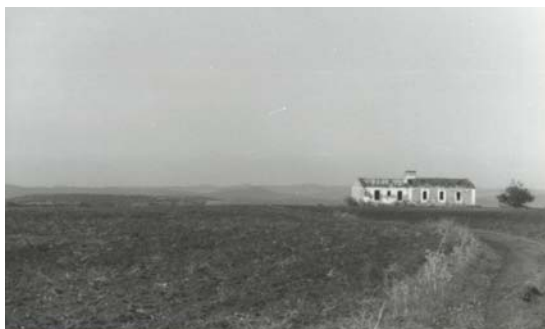
Puesto fiscal derruido (La Barraquera). María Sánchez Carrasco
