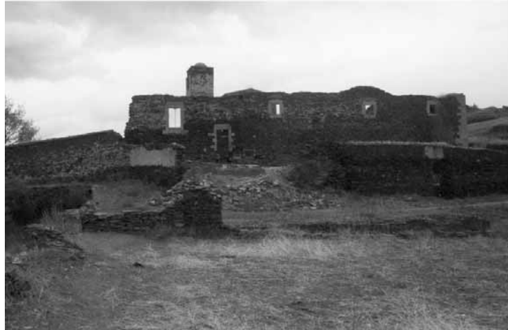
Fig. 14 Estado actual de la fachada del poniente
