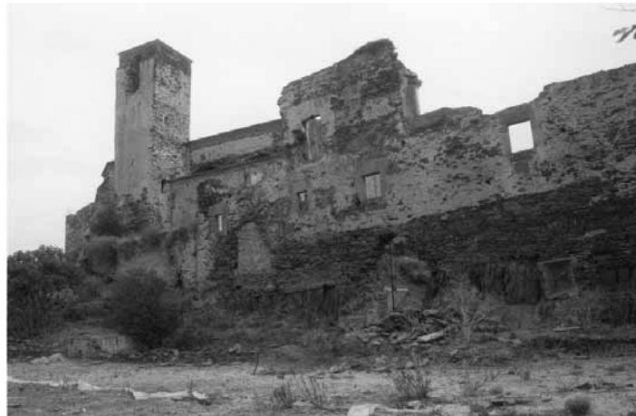
Fig. 12. Estado actual de la fachada del Covento que daba al Tajo
