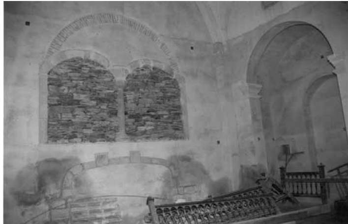
Fig. 11. Interior de la Iglesia de la Antigua. Coro alto y bajo tapiado
