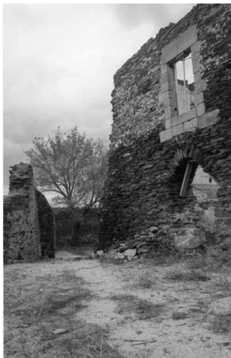
Fig. 16. Puertas que daban acceso al vergel y al huerto
