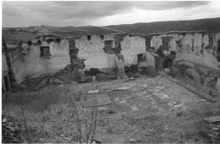
Fig. 15. Estado actual del claustro y ruinas de las dependencias actuales
