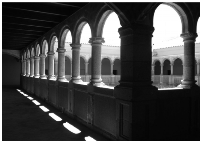
Un primer plano del corredor y la arquería superior del lado norte del claustro; en las galerías del fondo se distinguen las puertas de algunas de las celdas del convento.
