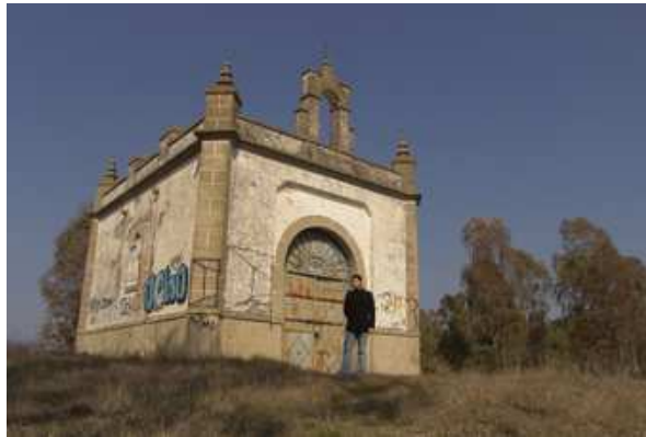
Figura 9. Estado actual de la primitiva ermita de San Isidro de Monesterio, construida en 1951.
