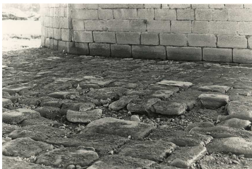
Fig. 2. La losa de cimentación de los nuevos arcos del Puente. Archivo MNAR (Foto M. de la Barrera).
