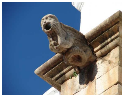
Fig. 11. Gárgola Estribo 4 Lado sur
