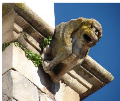
Fig. 12. Gárgola Estribo 5 Lado sur
