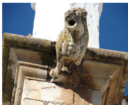
Fig. 13. Gárgola esquina Capilla del Sacramento.
