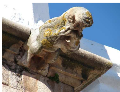
Fig. 9. Gárgola Estribo 2 Lado sur.
