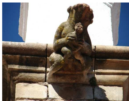
Fig. 7. Gárgola del estribo de la esquina SO
