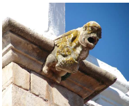
Fig. 8. Gárgola Estribo 1 Lado sur.
