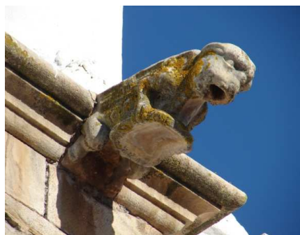
Fig. 10. Gárgola Estribo 3 Lado sur.
