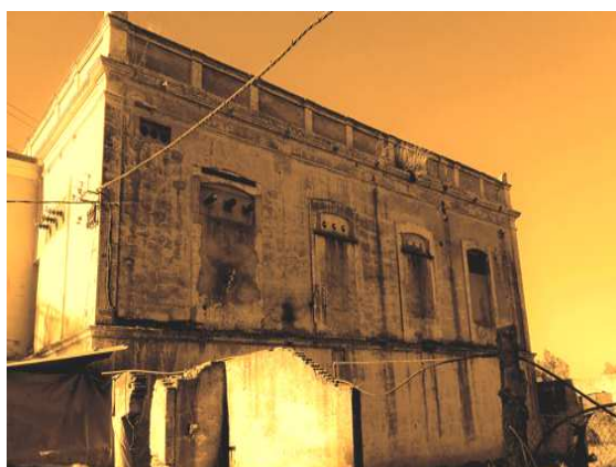
Estado actual del molino, a orillas del Guadiana, de aquella “fábrica de la luz” (J. Monzú).
