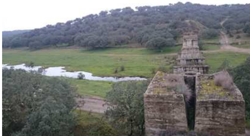
Pilares del puente sin terminar sobre el río Alcarrache en el lugar conocido como “El Salto del Lobo”
