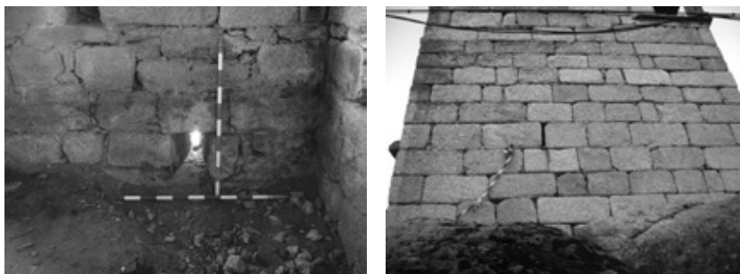
Imágenes 14 y 15: Tragaluz en el momento de su excavación y apertura exterior
