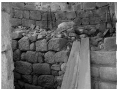
Imágenes 35 y 36: Escaleras en el interior de la torre y estrato de relleno que actuaba como sostén de las mismas.
