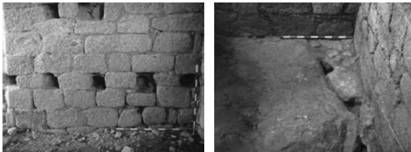
Imágenes 12 y 13: Mechinales y nivel original de escombros, relleno de desniveles en la base de la torre
