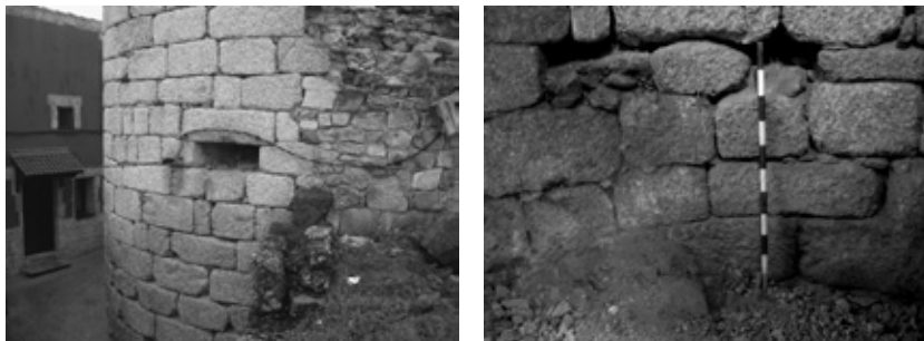
Imágenes 16 y 17: Tronera con abertura en forma de buzón y mechinales en la torre sureste
