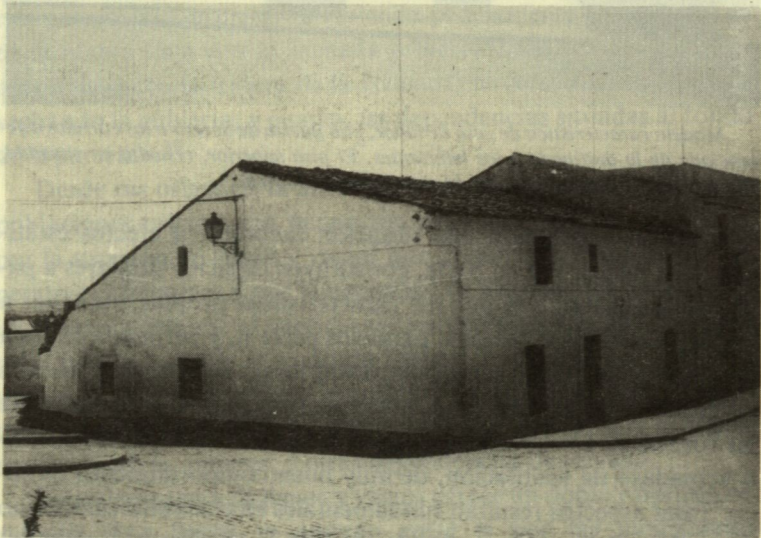
Perspectiva del modelo característico de casa popular bajoextremeña. Obsérvese la cubierta en dos pendientes, y el vuelco de los huecos hacia la parte anterior (calle) y la posterior (patio-corrал). Por tratarse de un edificio en esquina, excepcionalmente se abren huecos en el muro medianero. Talavera la Real.
