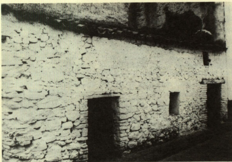
Casa de piedra correspondiente a la zona del noreste de la región. Aunque varía el material (no aparece el barro) la estructura de la edificación no varía respecto de las de la zona de llano. Capilla.
