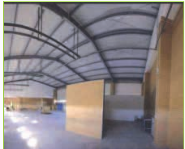
Obras de acondicionamiento de un parque.
