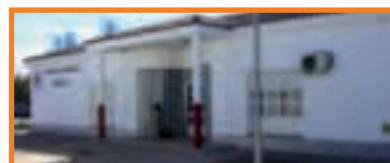
Parque Local de Fregenal de la Sierra Ctra. Badajoz-Huelva, s/n. 06340 Fregenal Tel.: 924 700 081. Corporativo: 2282 e-mail:fregenal.spei@dip-badajoz.es
