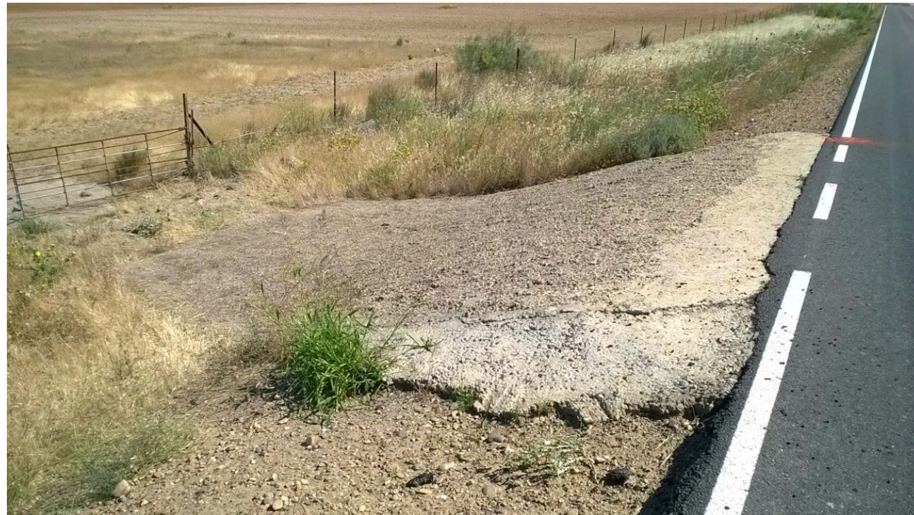
Acceso 21 (P.K. 3+600) – Margen Derecha
