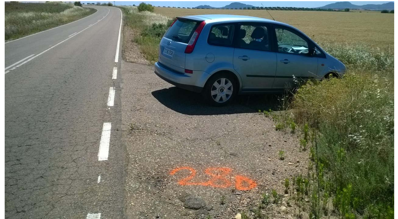
Acceso 28 (P.K. 5+600) – Margen Derecha
