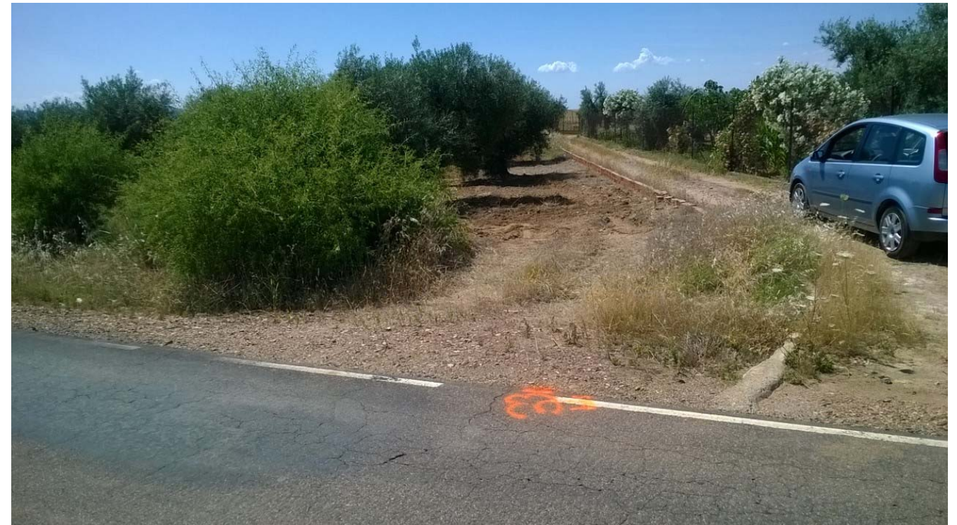
Acceso 33 bis (P.K. 6+750) – Margen Derecha
