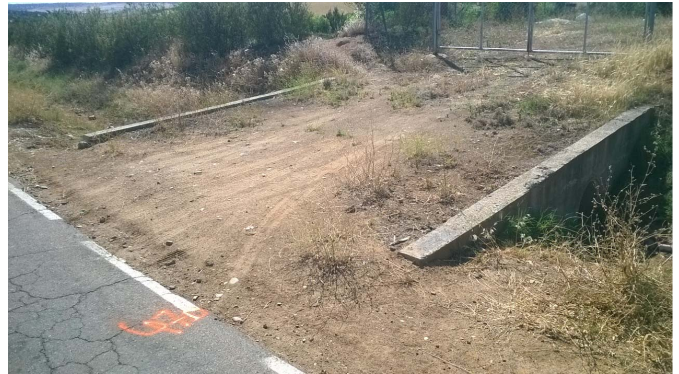
Acceso 47 (P.K. 8+180) – Margen Derecha
