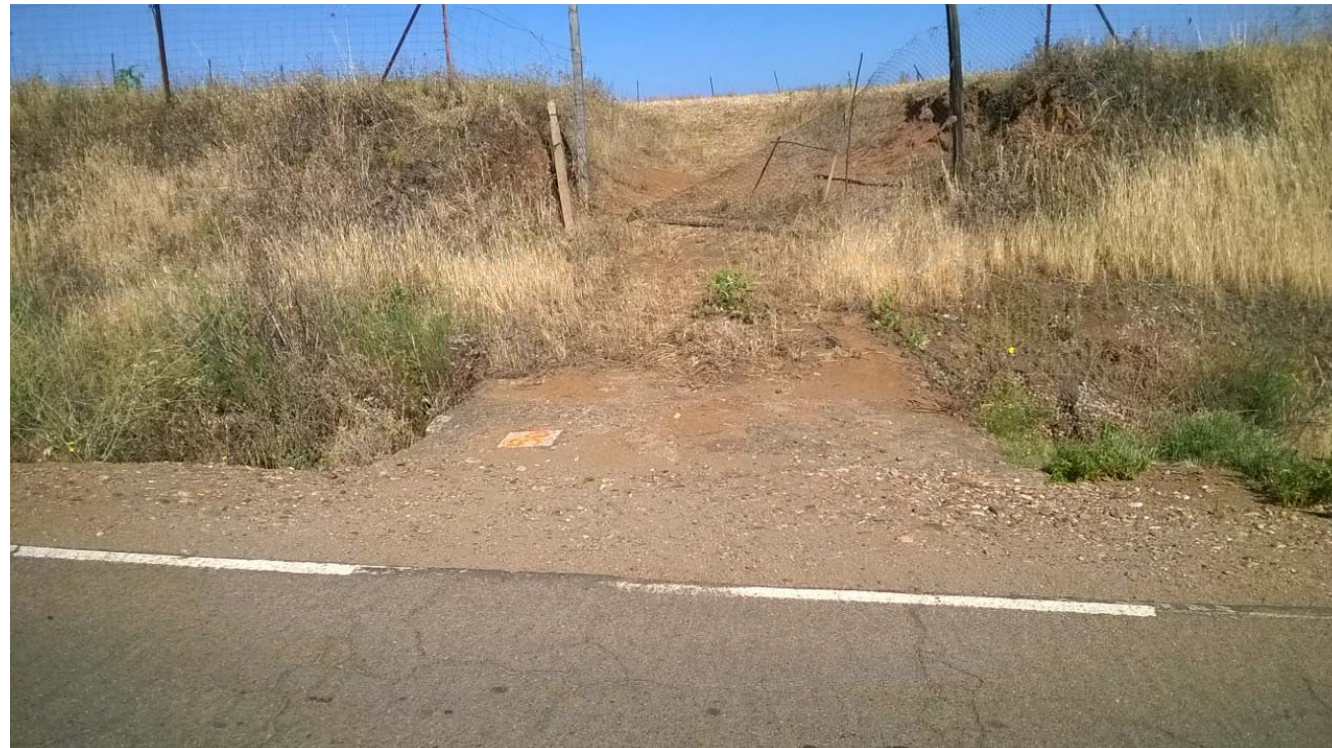
Acceso 5 (P.K. 0+165) – Margen Derecha
