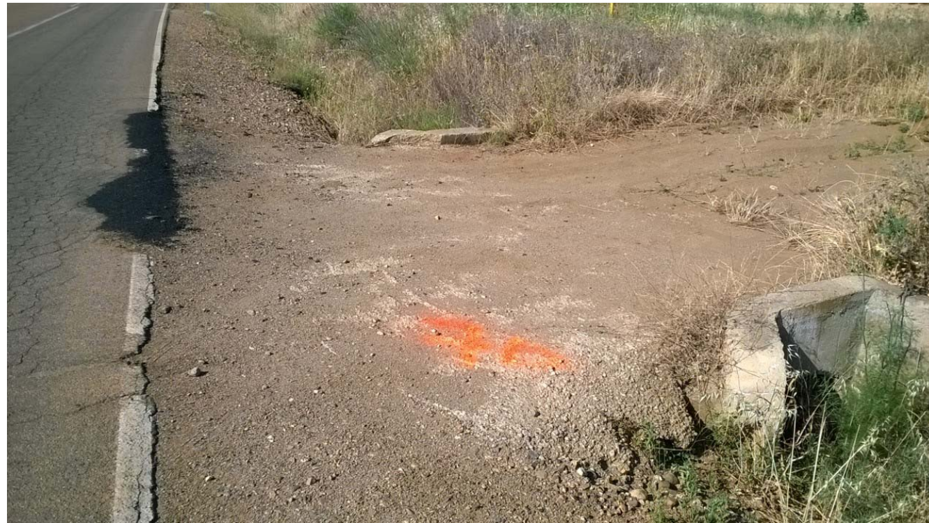
Acceso 7 (P.K. 0+255) – Margen Derecha
