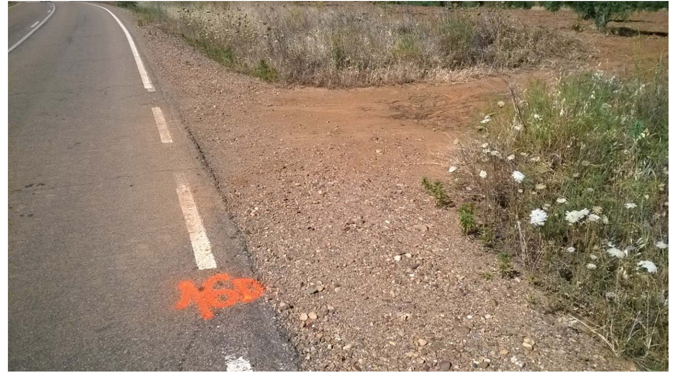
Acceso 16 (P.K. 2+060) – Margen Derecha
