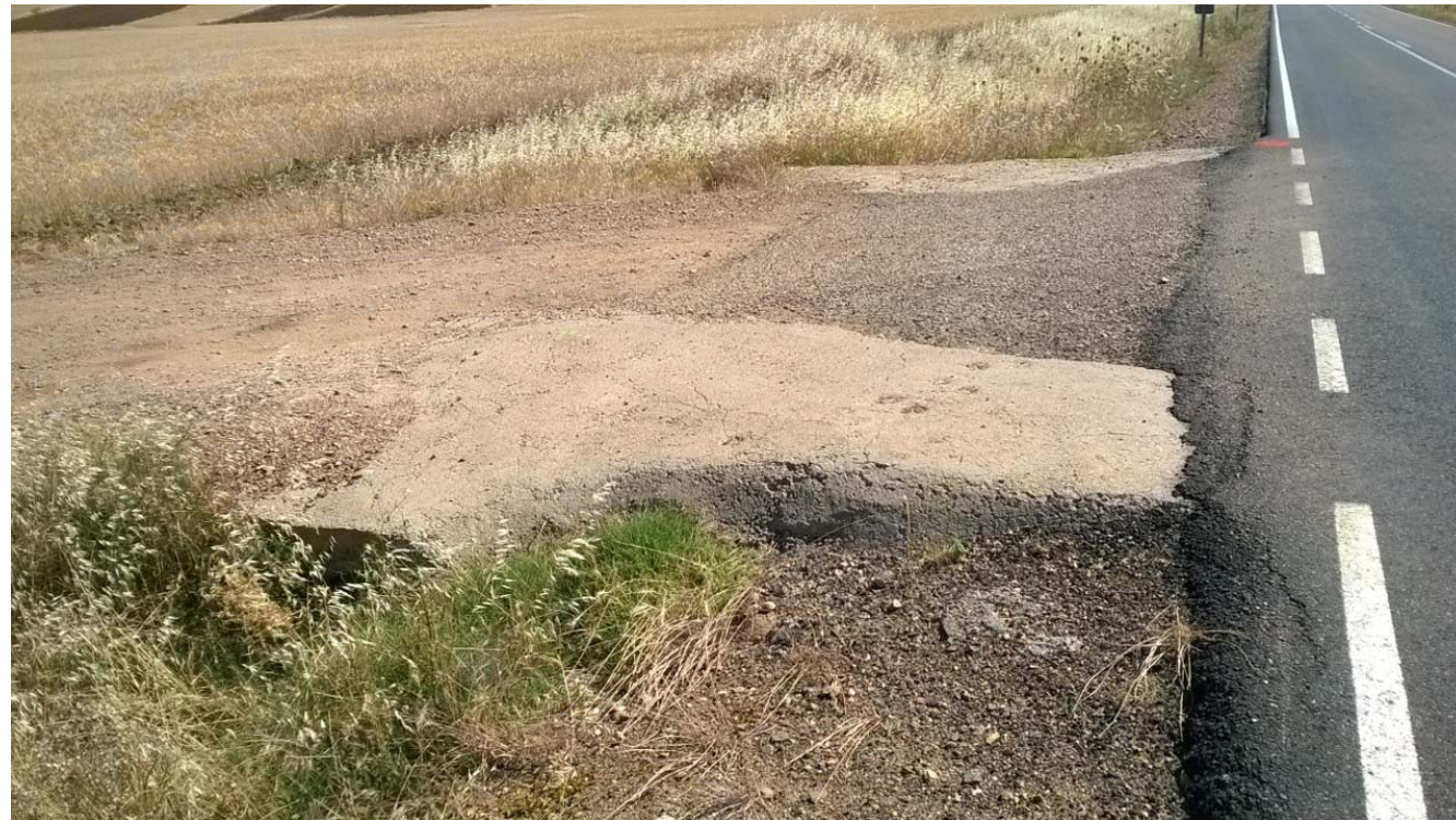
Acceso 19 (P.K. 3+010) – Margen Derecha
