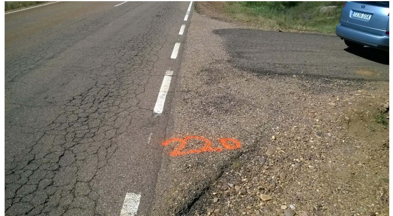
Acceso 22 (P.K. 4+130) – Margen Derecha
