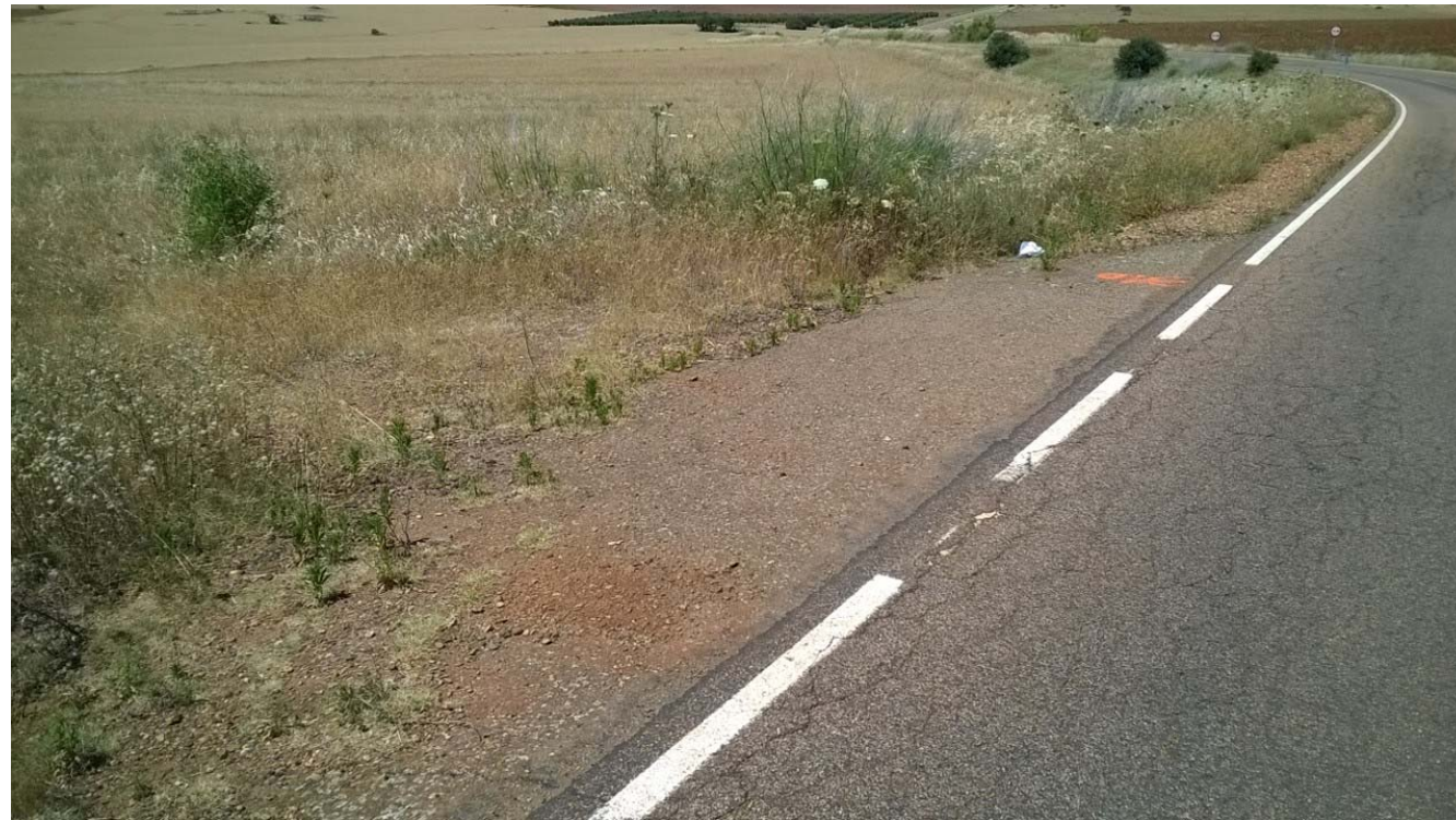
Acceso 31 (P.K. 6+030) – Margen Derecha
