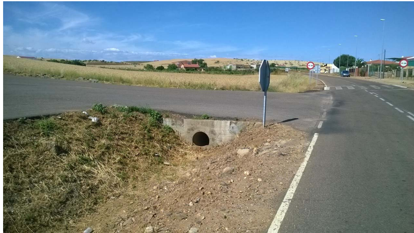
Acceso 50 (P.K. 8+350) – Margen Derecha
