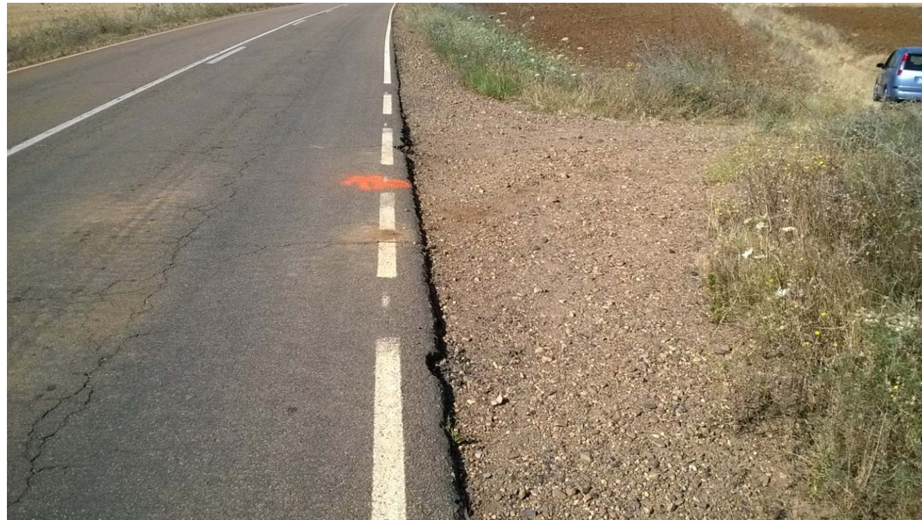
Acceso 11 (P.K. 0+960) – Margen Derecha
