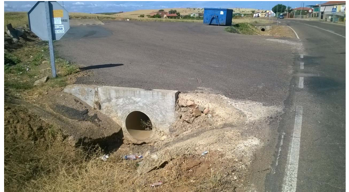
Acceso 51 (P.K. 8+400) – Margen Derecha
