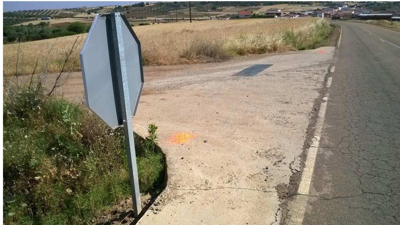
Acceso 9 (P.K. 0+430) – Margen Derecha
