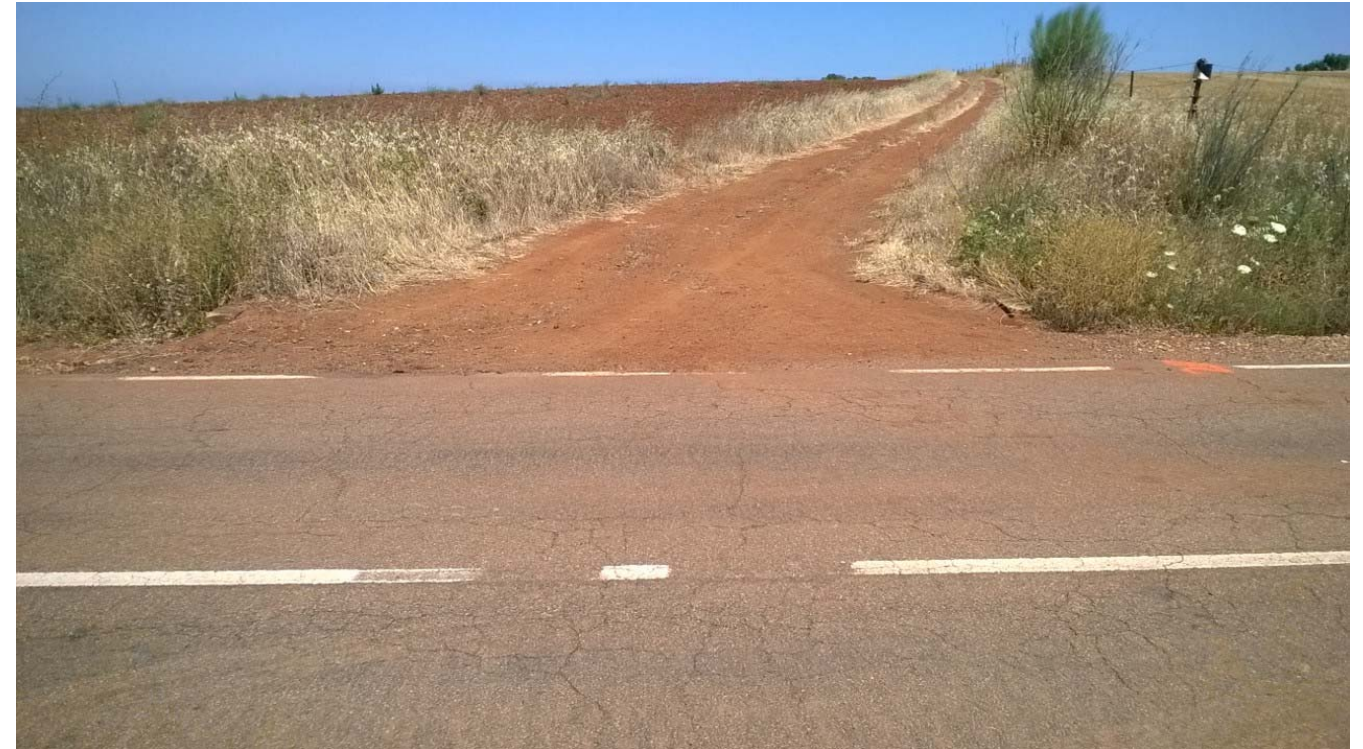
Acceso 26 (P.K. 5+025) – Margen Derecha
