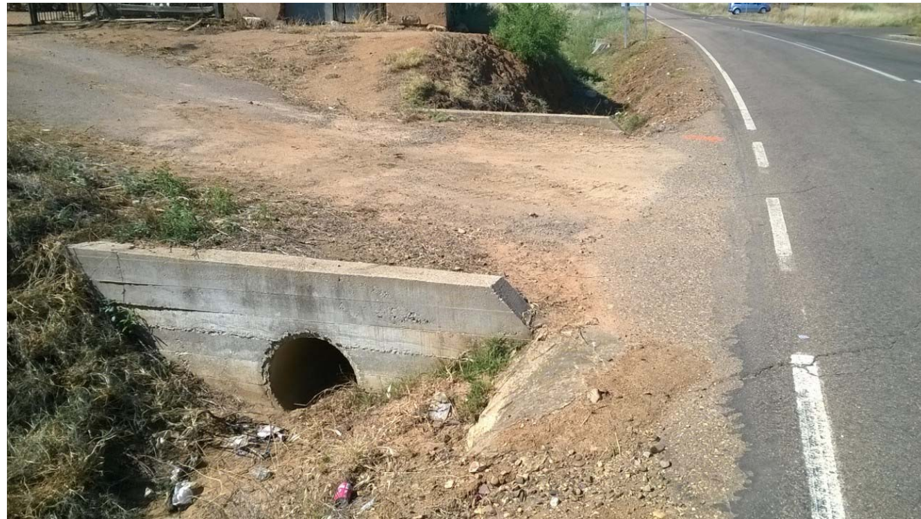
Acceso 46 (P.K. 8+130) – Margen Derecha
