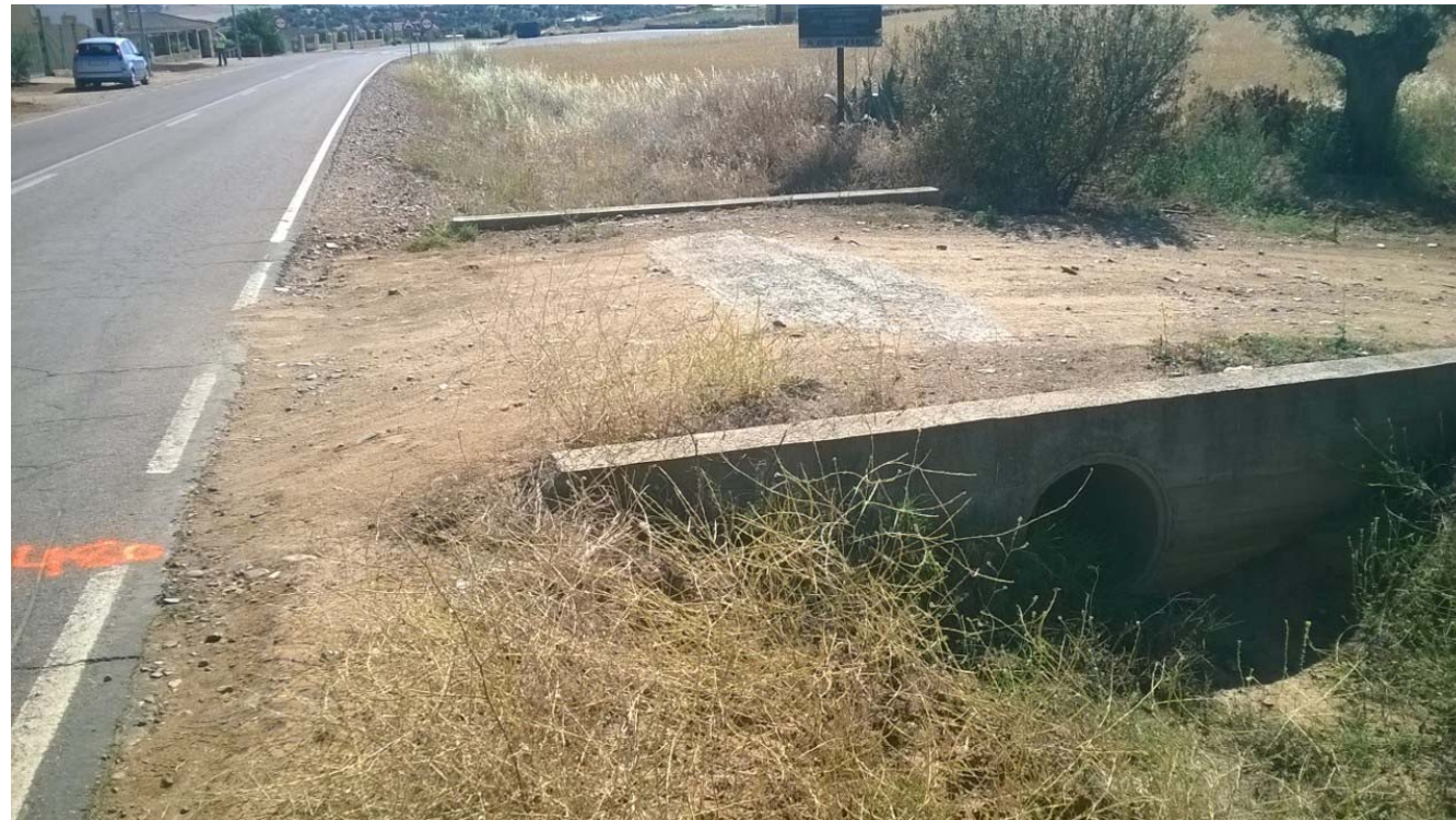
Acceso 48 (P.K. 8+240) – Margen Derecha
